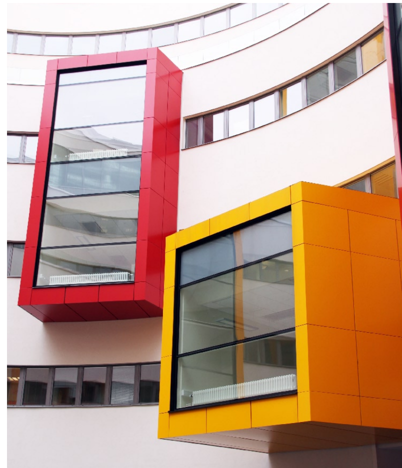
Akuten/infektionsbyggnaden i Malmö
